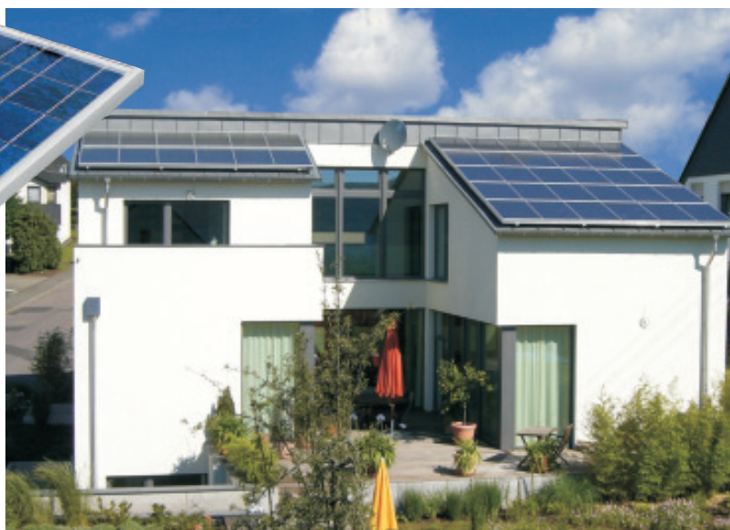
Passivhaus in Trier Strom und Wärme von der Sonne: rechts 5,4 kWp SolvisPico (Sonnenstrom), links 16 m 2 SolvisFera (Wärmekollektor), Aufdach-Montage
